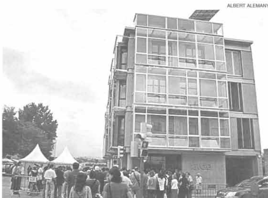
L'Ecoedifici de La Vola està situat a l'avinguda de Roma.
